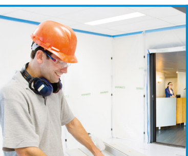
Poursuivre le travail pendant la rénovation d'un bureau
